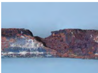
Rottura della barra per corrosione.
