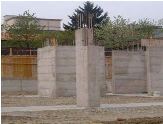
Pilastro incastrato alla base su fondazione continua.
